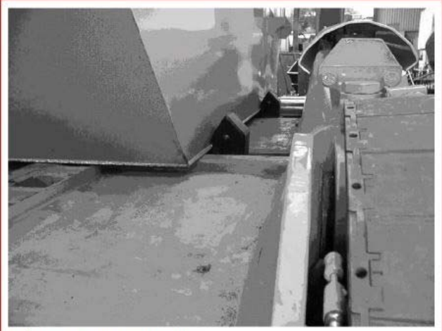
Sicherung Container zur Seite
